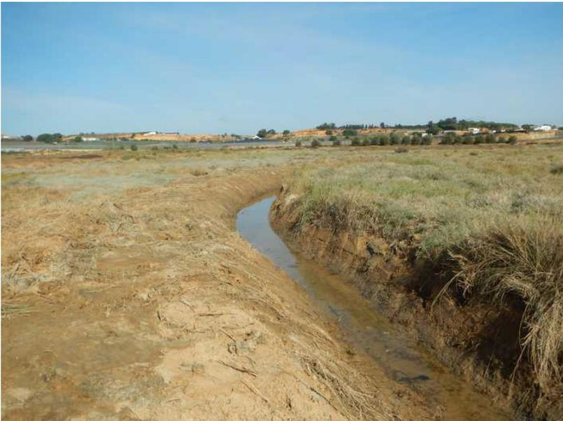
Fig. 23. Apertura de red de drenaje alterada por la acumulación de vegetación y de residuos sólidos; Marismas del Tinto, término municipal de Palos de la Frontera (parcela T34-T35; octubre 2020). Izquierda, antes de iniciar los trabajos de restauración hidrológica; derecha, aspecto una vez concluidas las actuaciones proyectadas.
